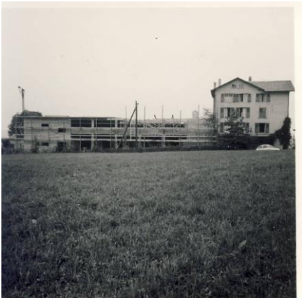
Erste Erweiterung 1948 (Ansicht von Norden)
