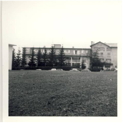
Aufstockung mit Dachwohnungen 1962 (Ansicht von Norden)
